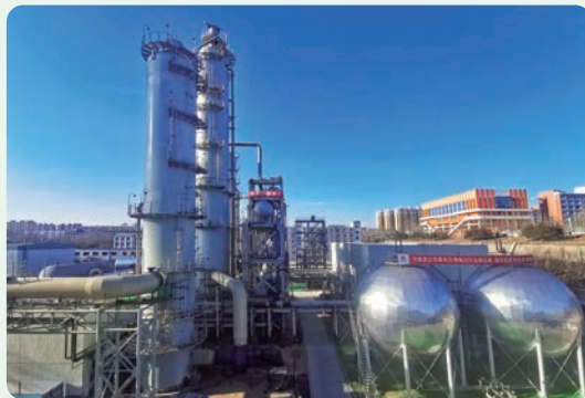
錦界能源CCS示範工程項目現場
