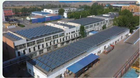
石圪台煤礦太陽能設備
