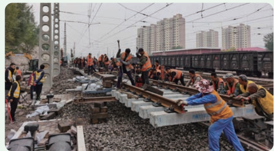
專用線鋪軌作業現場
